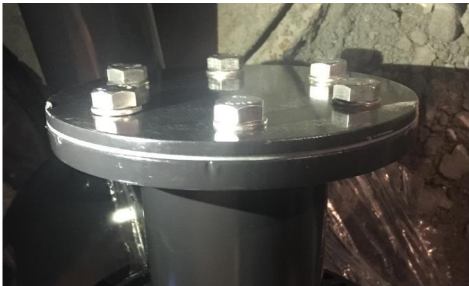
顶部铝合金通信法兰预留孔封堵示意
