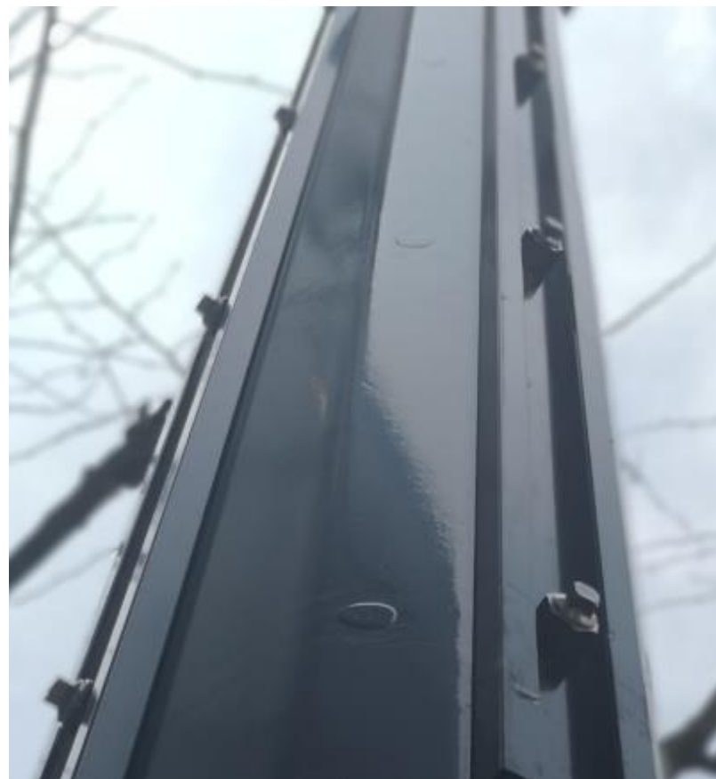
杆体导槽预留端口封堵
